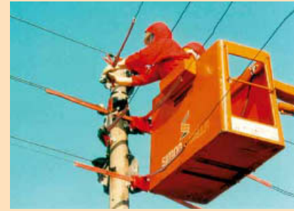
2 Arbeiten unter Spannung mit isolierendem Anzug
