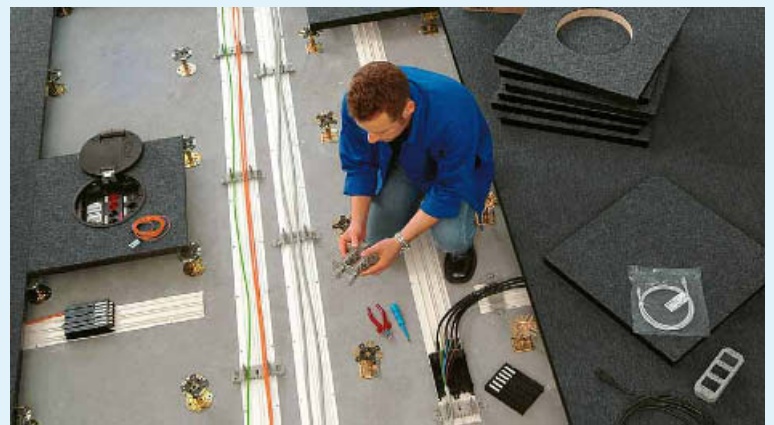
19 Positionierung eines Consolidation Points CP unter den Bodenplatten als Kombination aus steckbaren Energie- und Datenverteilern zum Anschluss von Raumsäulen, Raumverteilern und tischhohen Installationssäulen
