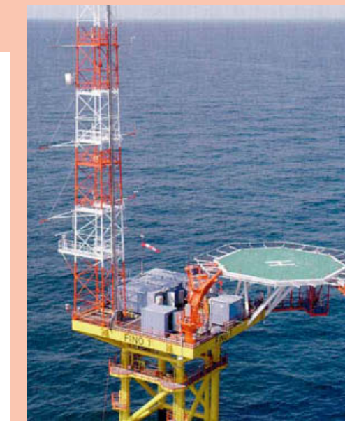
③ Plattform FINO 1 in der Nordsee dient Forschungsvorhaben für Offshore-Windparks
