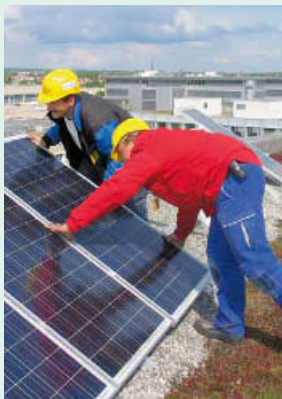
② Mit Kies abgedeckte Leitungen sind bei Montage- und Wartungsarbeiten mechanischen Belastungen ausgesetzt.
