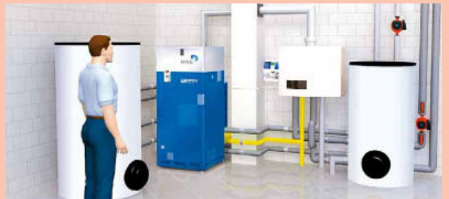
8 Beispielhafte Darstellung des BBT-Brennstoffzellen-Heizgerätes bestehend aus Heizwasser-Pufferspeicher, Brennstoffzelle, Zusatzheizgerät und Warmwasserspeicher
