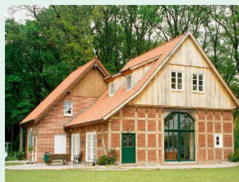
1 Intelligente Gebäudetechnik hinter denkmalgeschützter Fassade
