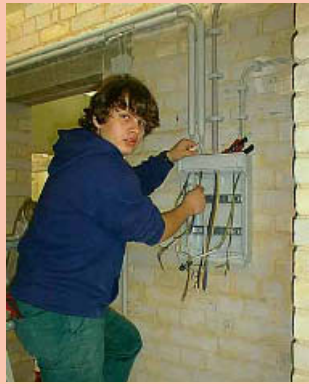
③ Der Auszubildende M. Kunze beim Anschluss der Unterverteilungen
