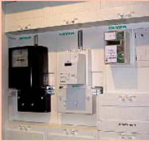
② Zählerplätze für elektronische Haushaltszähler eHZ links: Ferrariszähler Mitte: eHZ mit Adapter für bestehende Anlagen rechts: eHZ-Zählerplatz
