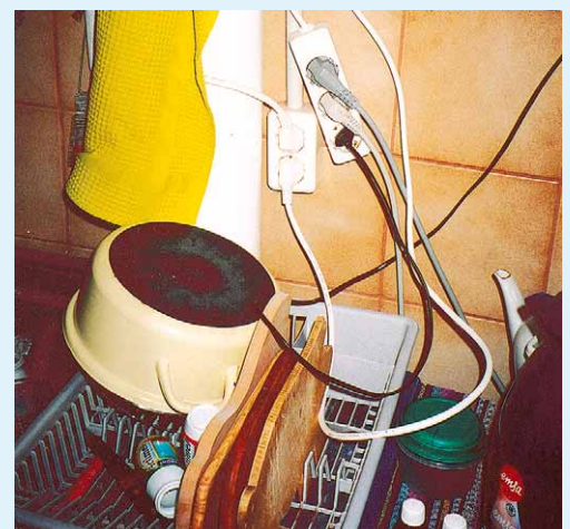
1 Beispiele für unsachgemäße „Nachinstallationen“
