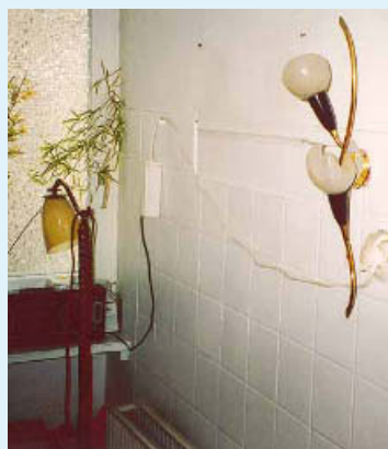
1 Beispiele für unsachgemäße „Nachinstallationen“
