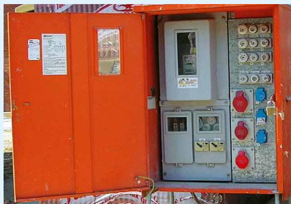
❶ Baustromverteiler
