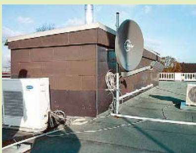
❸ Nicht in den Blitzschutz einbezogene Antennenhaltekonstruktion
