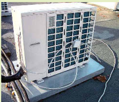
❷ Am Klimagerät nur „eingehängte“ Abzweigdose
