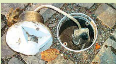
❺ Installation der Fahrbahnbeleuchtung
