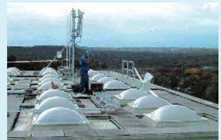
1 Flachdach mit speziell gestalteten Verkehrswegen – die Lichtkuppeln sind nicht betretbar
