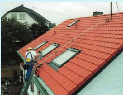
4 Schaffung eines Anschlagpunkts für PSAgA durch Einsatz einer Hakenstange
