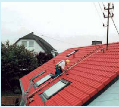
3 Begehung eines Satteldachs unter Benutzung persönlicher Schutzausrüstungen gegen Absturz und Zuhilfenahme einer Dachauflegeleiter
